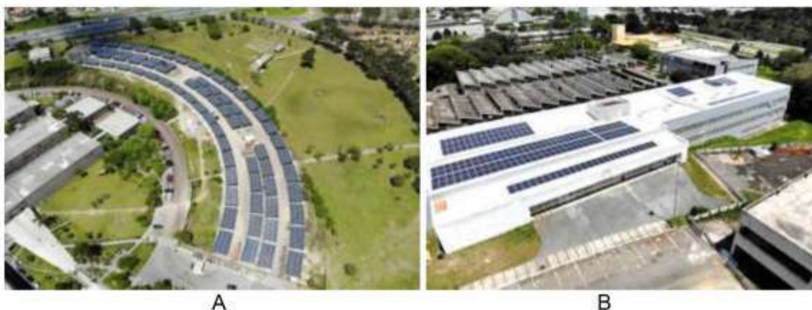
FIGURA 9 - USINA FOTOVOLTAICA DO PROJETO COPEL NO CENTRO POLITÉCNICO
